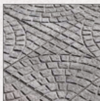
Pavimentazione in Cemento
